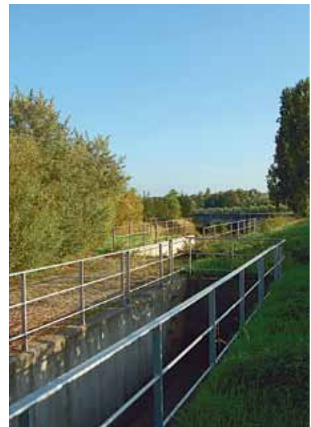
100 Jahre alt, 50 Meter tief: der Trinkwasserbrunnen nahe der Bahn.
