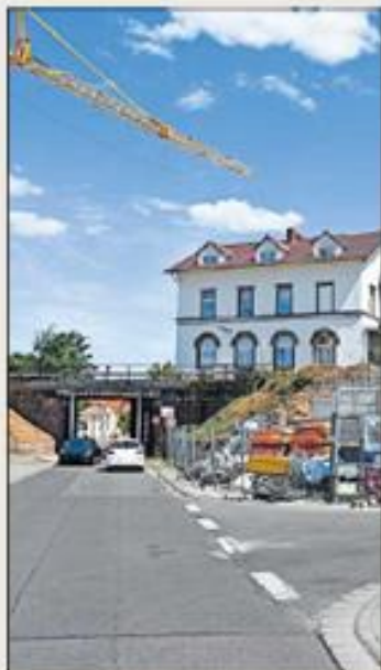
Die Bahnhofstraße in Freinsheim verläuft unter der maroden Bahnbrücke. FOTO: PETER KRETZSCHMAR
